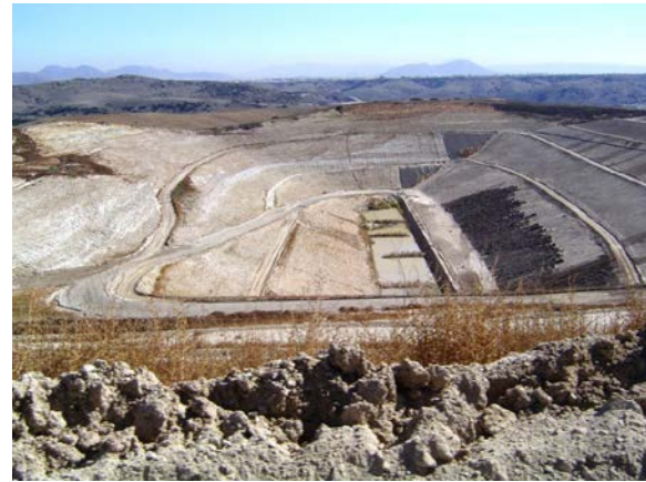
Otay County Landfill
